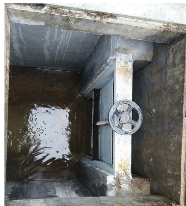
雨水总闸照片
