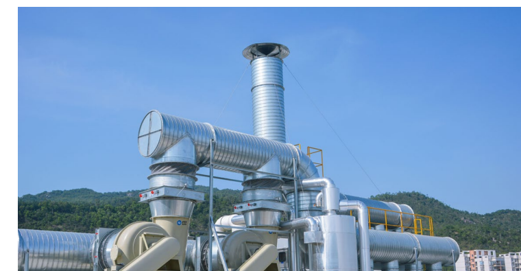
超毅电子的车间内废气吸收装置及车间外吸收塔
