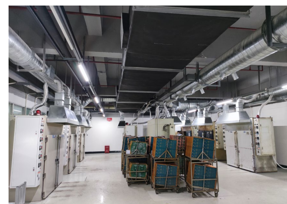
德丽科技的车间内废气吸收装置及车间外吸收塔
