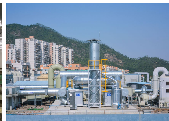
超毅电子的车间内废气吸收装置及车间外吸收塔
