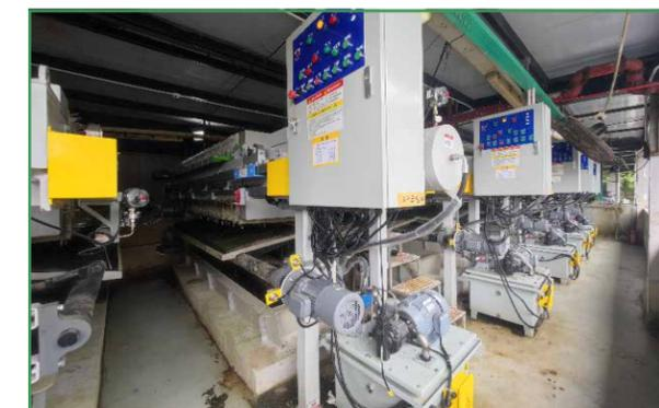
更新8台高效压滤机，有效减少污泥中的含水率
